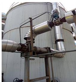
3、上面的左图，是 2014 年安装在中国石化的岳阳兴长公司，流量为 500/时的“汽水混合器”。上面的右图，是 2013 年悬空安装在湖南、怀化骏泰浆纸的流量 220 吨/时的汽水混合器，用于造纸厂的白水加热。
